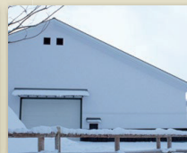
Miasa Highland Aging Warehouse
